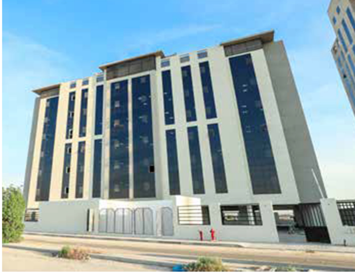
الوضع الحالي للمبنى
